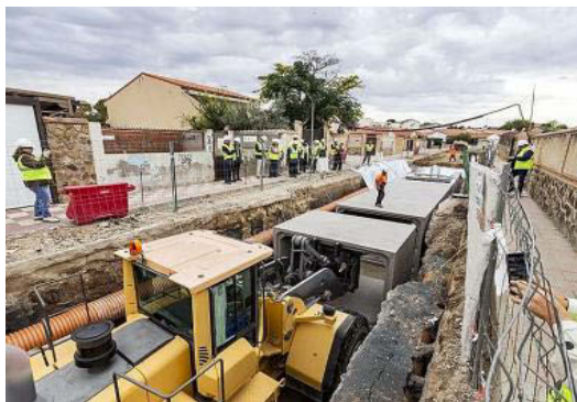
El acoplamiento de una estructura de hormigón. / DAVID PÉREZ
