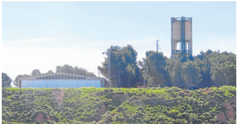
Imagen de los depósitos del monte La Plana, desde donde se distribuye el agua de boca al municipio. E. P.
