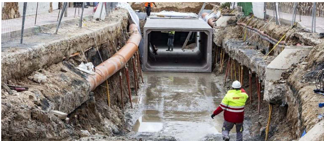
La canalización por una calle de la localidad. / DAVID PÉREZ
