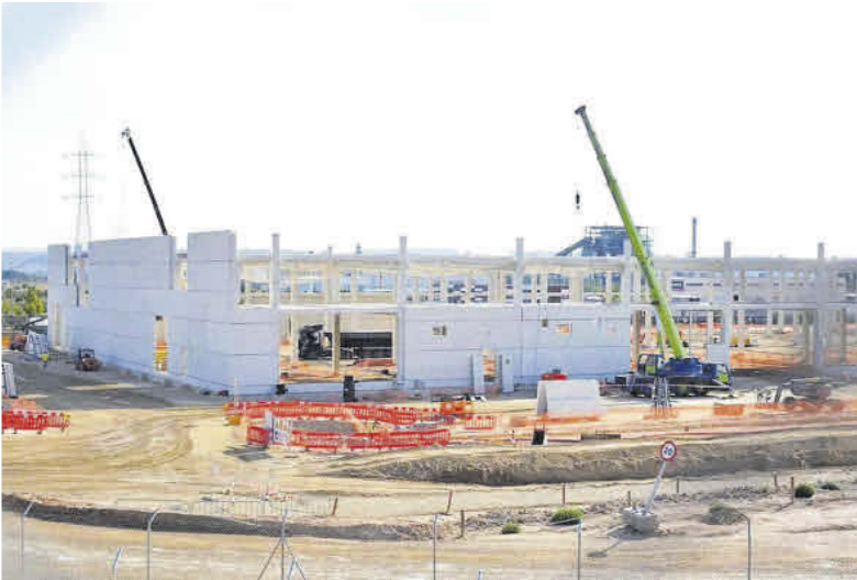
Construcción del centro de datos de Amazon en El Burgo de Ebro, en una imagen reciente.
