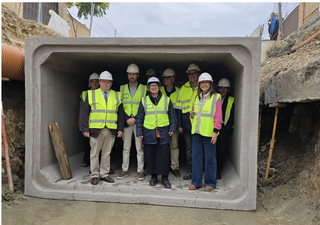
La consejera de Desarrollo Sostenible ha visitado la nueva canalización del arroyo de la Degollada en Cobisa JCCM
